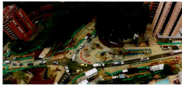
Imagen actual de la obra
