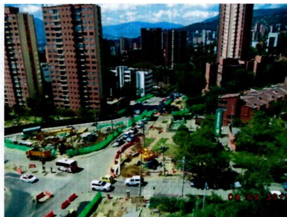
Imagen actual de la obra
