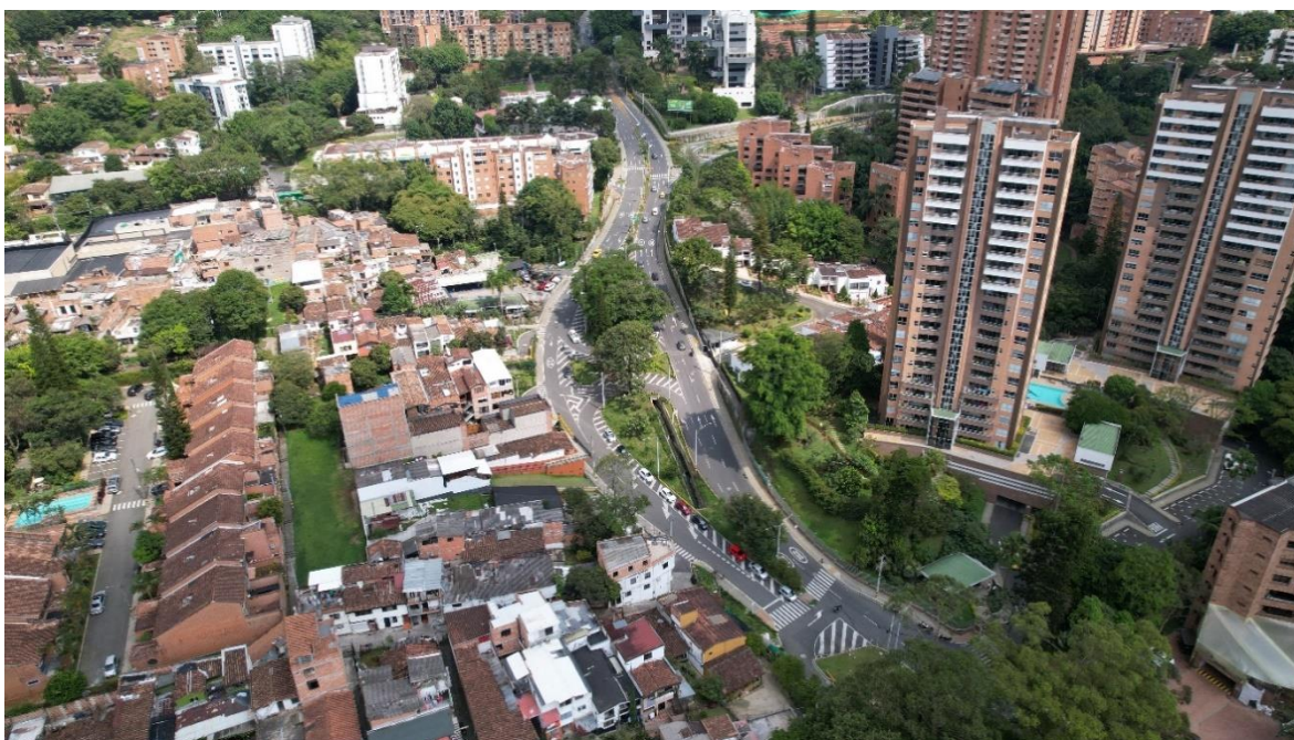
Ilustración 3. Obra paso a desnivel de la transversal inferior con la Loma de Los Gonzalez
