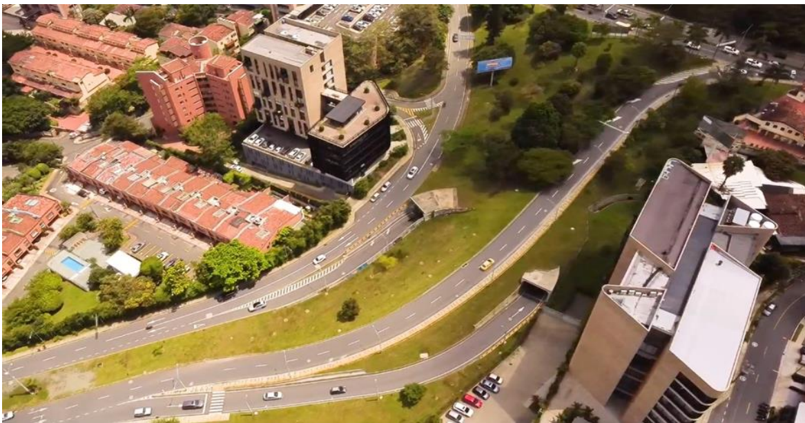
Ilustración 3. Ampliación de la segunda calzada avenida 34 entre la AV43a y la carretera las palmas - Tramo Escopetería - Calle 13
