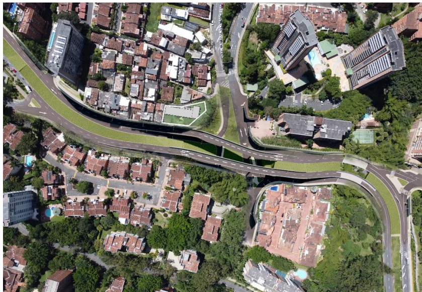
Intercambio vial de la avenida 34 con la loma de Los González
